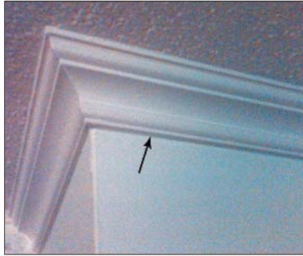
Bild 4: Leitung mit biegeunempfindlichem Lichtwellenleiter (Foto: OFS)
