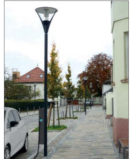
Bild 1: Straßenbeleuchtung mit Zusatznutzen: An der Ladestation „Karsten“ tanken E-Autos auf (Foto: Leipziger Leuchten)
