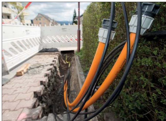
Aufrüstung und Modernisierung: Auch bestehende Kabelnetze können zum Breitbandausbau beitragen
