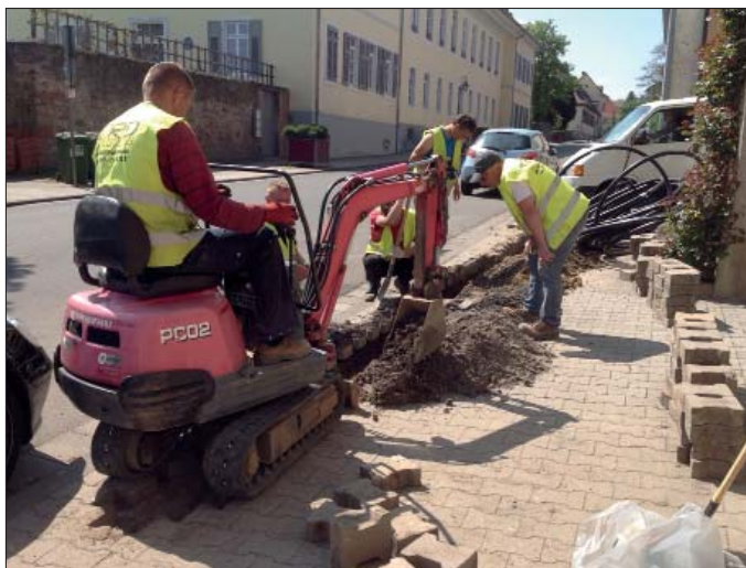
Tiefbauarbeiten im rheinland-pfälzischen Kirchheimbolanden
