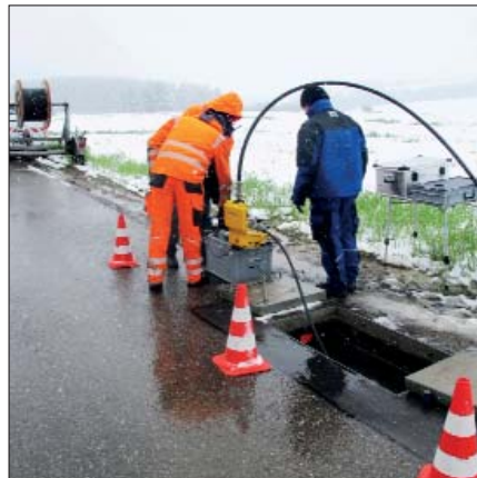
Bild 2: Das Einblasen von Glasfaserkabeln gelingt auch noch bei geringen Minustemperaturen (Quelle: Vetter)
