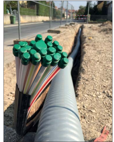
Filigrane Glasfaserkabel ermöglichen leistungsstarke Internetverbindungen. Dabei müssen sie bestens geschützt und für Anschlüsse vorbereitet werden, wie hier mit Rohrverbunden und Endkappen (Foto: Rehau)
